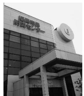
福岡市民防災センター
